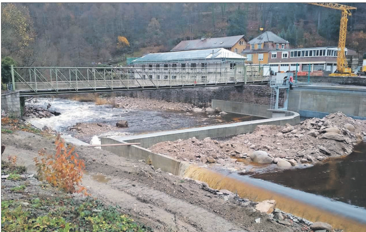
Die Wehranlage Schlechttau ist bereits umgebaut.
